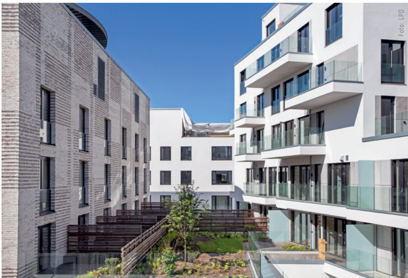
Fasaden på tilbygget – baksiden av hotellet – er kledd lys tegl, mens boligfasadene er pusset. Bak hotellet, og integrert med dette, er det bygget 56 nye leiligheter i størrelse 40–300 kvadratmeter med felles takterrasse. Disse har store vindusflater og luftige balkonger, men samtidig et tidløst og rolig fasadeuttrykk
